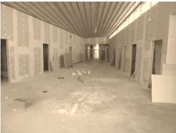
Flur, rechts Wirtschaftsräume, Toiletten usw, links Gruppenräumen
