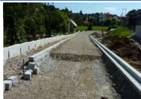
Links: Aufgang vom Schallergelände
