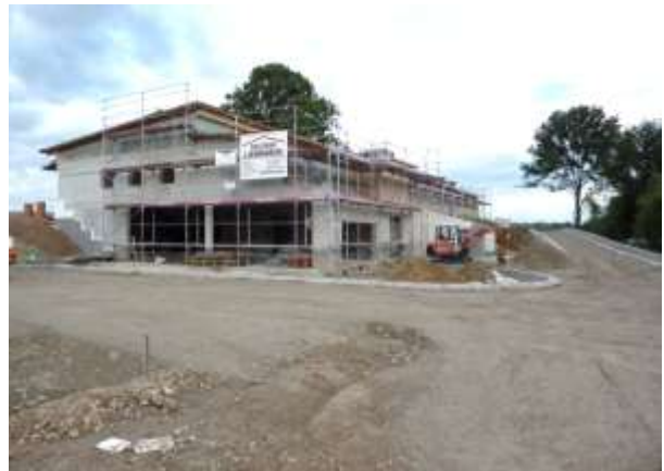
Baustelle KiTA Anfang Juli 2011
