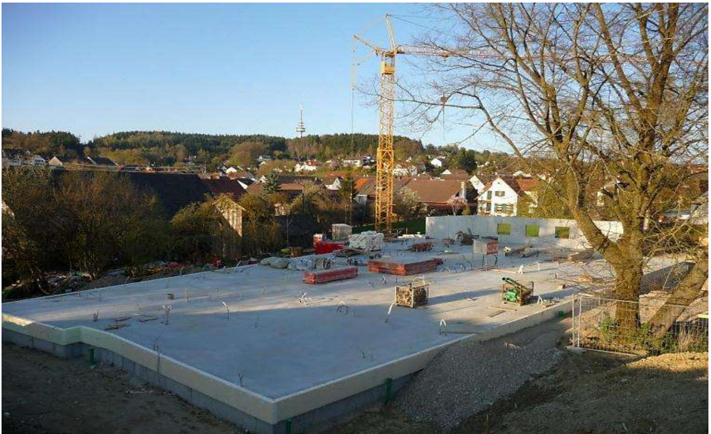
Baustelle KiTA im April 2011
